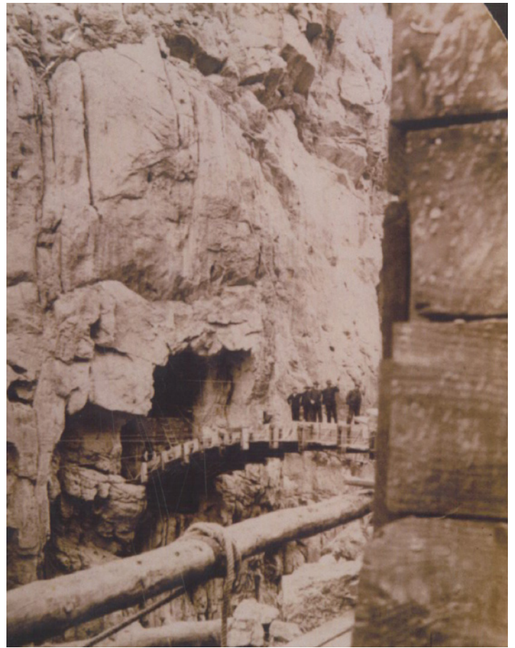
BALCÓN DE LOS GAITANES EN CONSTRUCCIÓN ( 1904 ).
