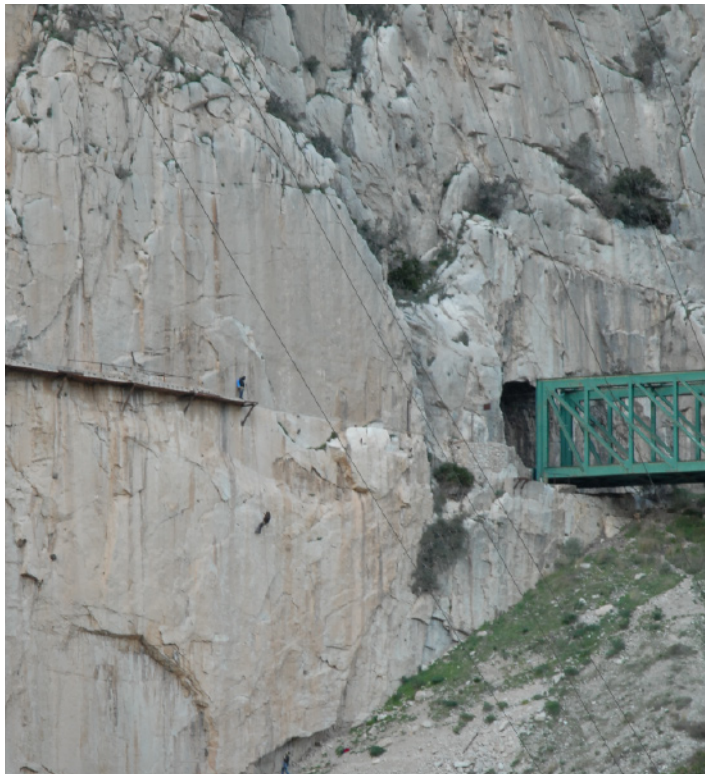
ENTRADA AL CAMINO DESDE EL PUENTE FERROVIARIO DEL CHORRO (EN PARTE DERRUIDO).
